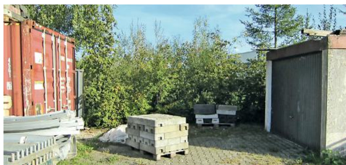
Die Garage wurde aufgehebelt, der Seecontainer wurde aufgebrochen.
